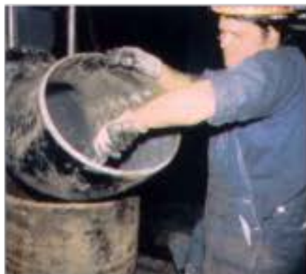
Bên trong ống được sửa chữa và phủ sơn bởi
